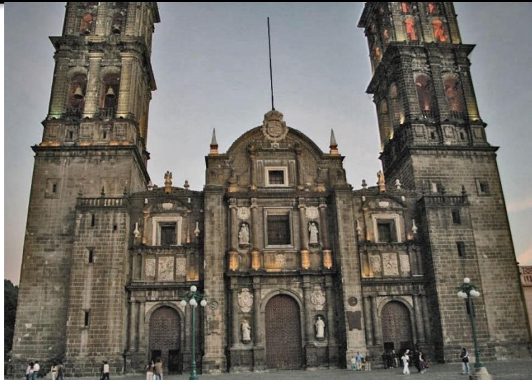
Imagen 24. Fachada Principal de catedral
