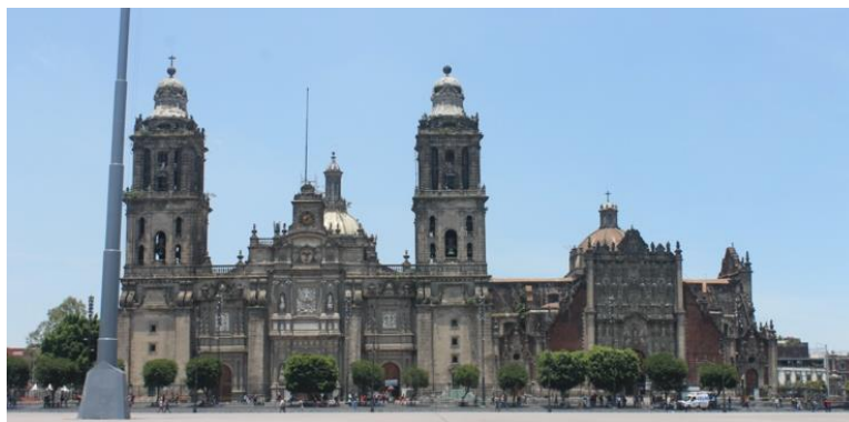
Imagen 4. Fachada Principal de la Catedral Metropolitana
