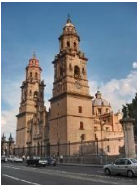
Imagen 13. Panorámica de Fachada Principal
