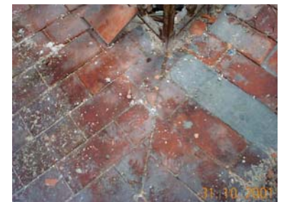
Lozas originales de los balconajes interiores
