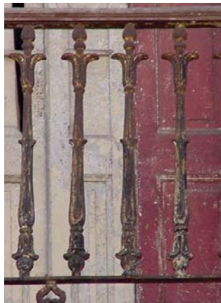
Barandas de los balcones
