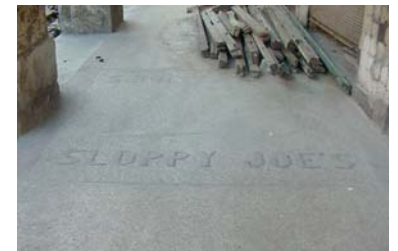
Terrazo original del portal
