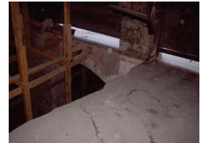
Pavimento del Bar
