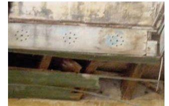
Ventilación de los falso techos
