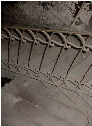
Barandas de escaleras
