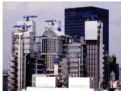
Edificio del Lloyds Bank en Londres
