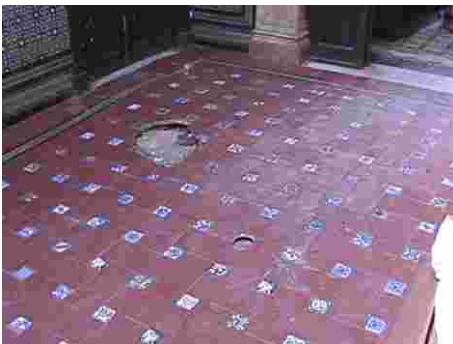
Levantamiento de los pisos en el interior del inmueble
