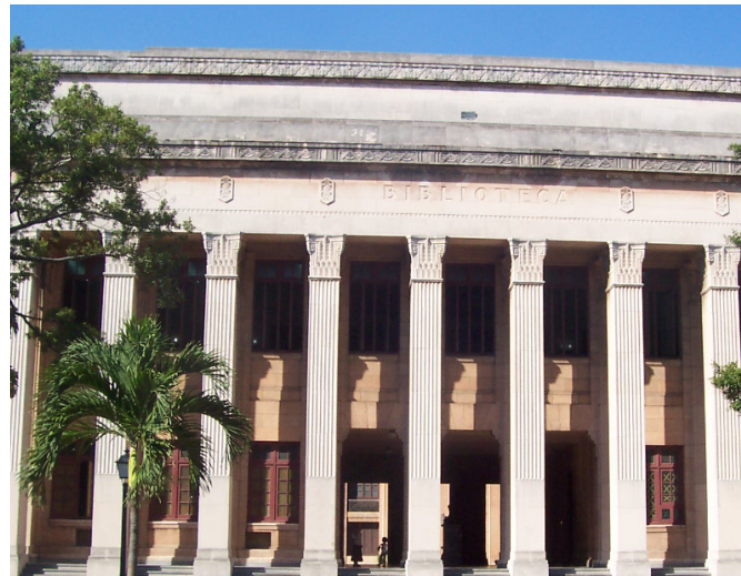
Edificio de la biblioteca de la Universidad de La Habana.
