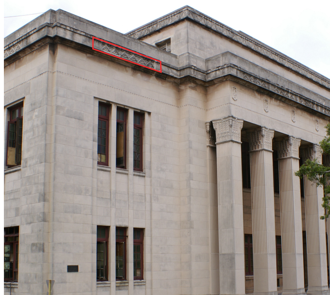
Edificio de la biblioteca, de donde se tomaron los motivos arquitectónicos.
