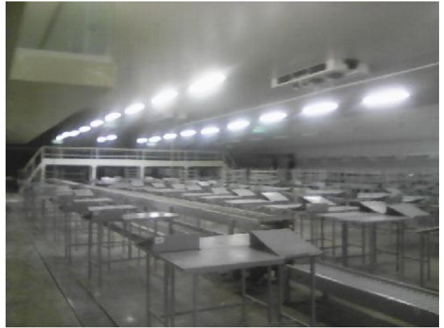
Instalaciones de planta Agrícola San Juan
