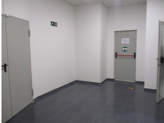
Fig. 28. Vestíbulo anterior al acceso del depósito, donde podemos encontrar dos puertas de acceso más de uso exclusivo en caso de emergencia, siniestro y necesidad de evacuación. Fuente: Blanca Galán Gil.
