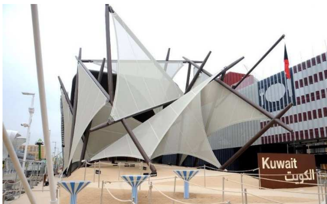
FIGURA 38. Pabellón de Kuwait Expo Milán 2015 (Fuente: http://cdn-media.ingegneri.info/wp-content/ )
