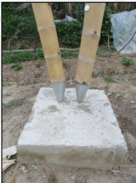
Fig. 12. Columnas de bambú para el prototipo de un vivero en Granada, España, empleando conos de acero para transmitir las cargas de compresión hacia los. Fuente: Ana María Cruz Valdivieso, España (2009).
