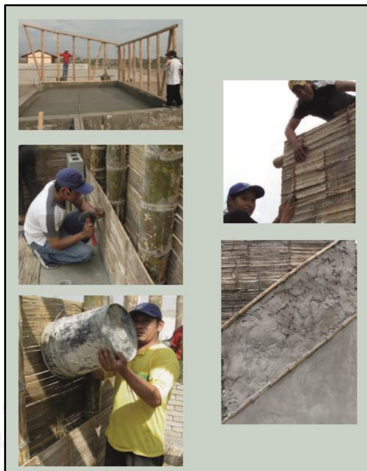
Fig. 21. Proceso constructivo de paredes Bahareque. Fuente: Morán, Perú (2015).
