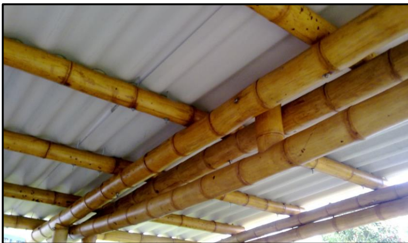
Fig. 25. Cubierta de calamina de policarbonato en un garaje. Este tipo de materiales suele ser duradero, liviano y barato. Fuente: Bambusa (2014).
