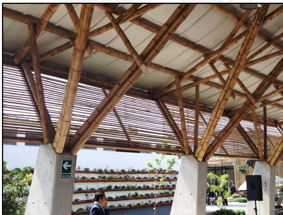
Fig. 17. El uso de elementos compuestos por varias cañas también se presenta en arriostres, como por ejemplo en este auditorio.
