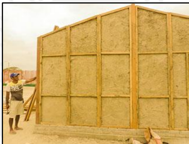
Fig. 7. Ejecución de los trabajos de construcción de las viviendas de bambú en Piura.
