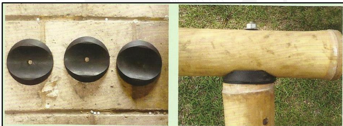
Fig. 28. A la izquierda, algunos de los conectores de caucho diseñados por Adán Piza. A la derecha, el nudo empleando dicho conector. Fuente: Minke (2012)
