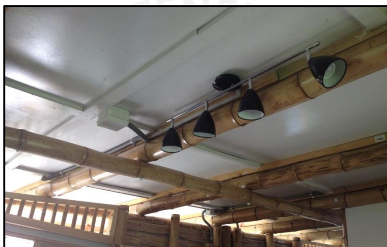
Fig. 42. Instalación de puntos de iluminación en el cielorraso de una vivienda, adosados al techo de drywall y a las cañas de las vigas.
