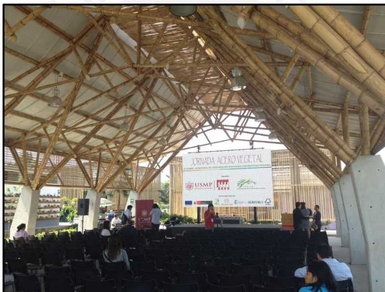
Fig. 26. Techo de un auditorio abierto en el distrito de Santiago de Surco. Los aleros poseen una cubierta de paneles de triplay, mientras que la parte central es caña de bambú chancada, que permite paso de luz natural, teniendo encima una pequeña cubierta adicional para evitar el paso de la lluvia.
