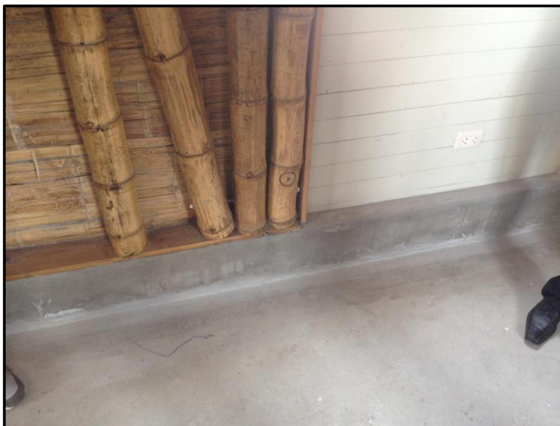
Fig. 10. Sobrecimiento de 20 cm de concreto en casa de bambú.
