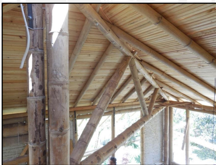
Fig. 24. Techo de bambú machihembrado en una vivienda en Guatemala. En este caso el techo es piramidal, de 4 lados, y se soporta con 4 cerchas que coinciden en una columna central. Fuente: Minke (2012)
