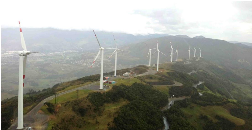
Figura 44: Parque eólico Villonaco
