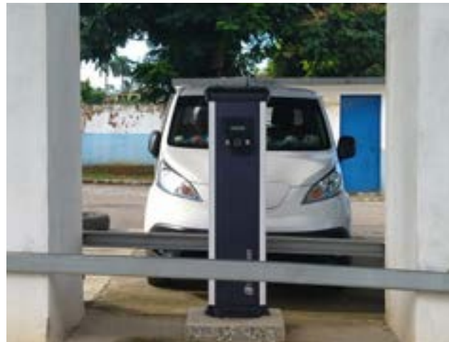
Torre de carga
