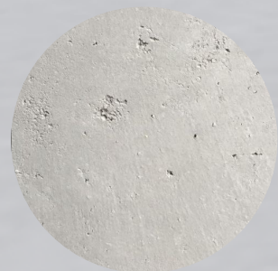
Base de concreto
