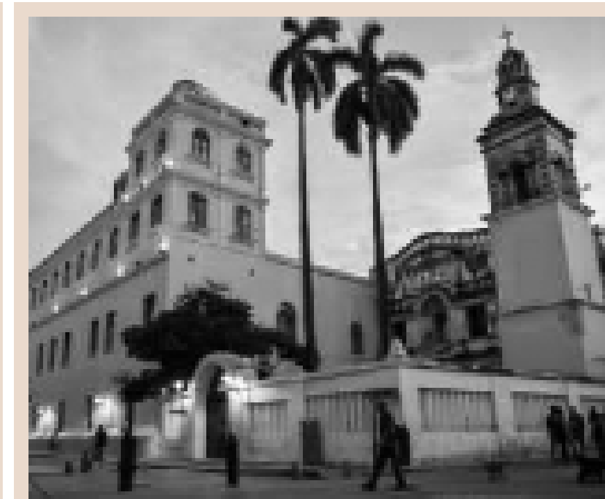
Centro de Convento de Belén
