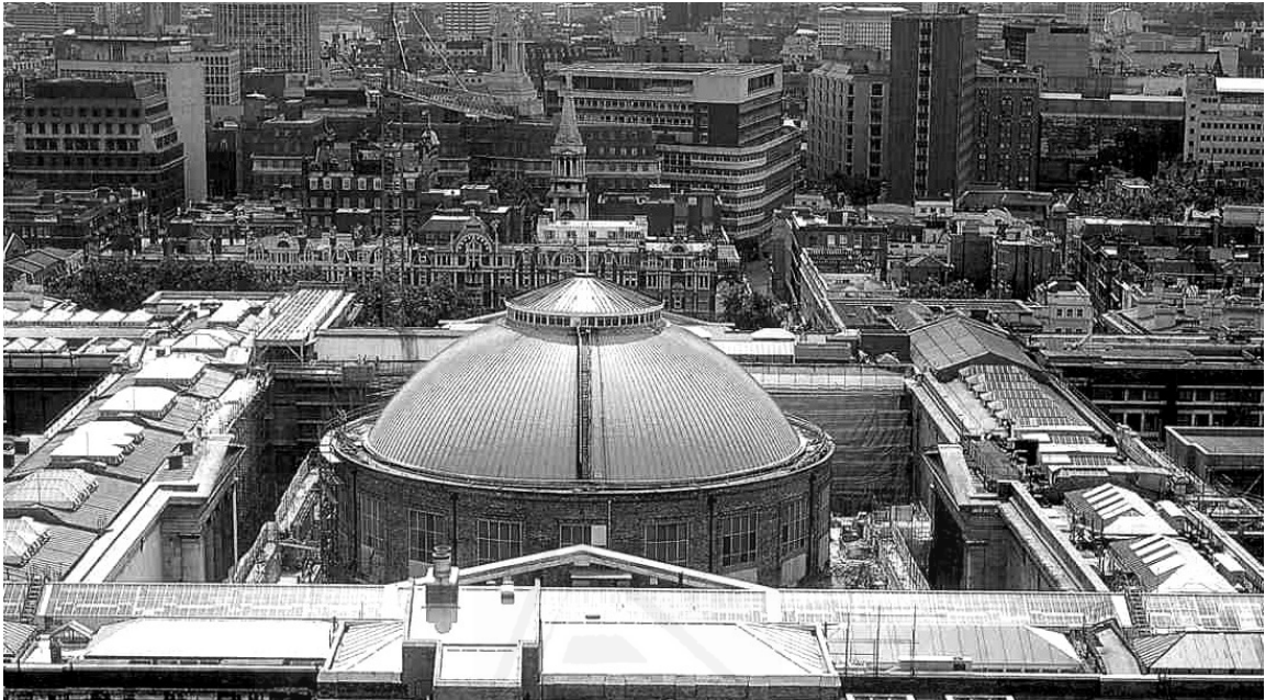
Imagen 90: Vista aérea del patio antes de los inicios de la obra. Ilustración extraída de " Norman Foster and The British Museum " (Foster et al., 2001, p.62).
