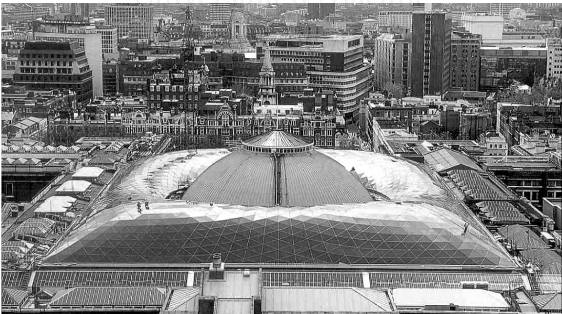
Imagen 91: Vista aérea del patio luego de finalizada la obra. Ilustración extraída de " Norman Foster and The British Museum " (Foster et al., 2001, p.63).
