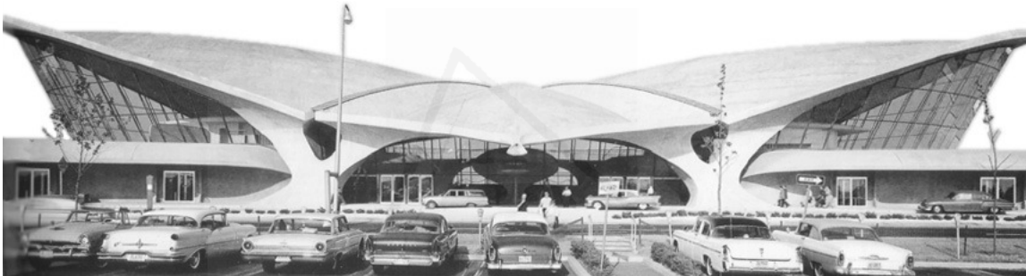
Imagen 112: Fachada principal de la Terminal de pasajeros de la TWA del Aeropuerto Kennedy en Nueva York. Ilustración extraída de "Eero Saarinen. TWA Terminal. Il calcolo e l'invenzione" (Papademetriou, 2001, p.27).
