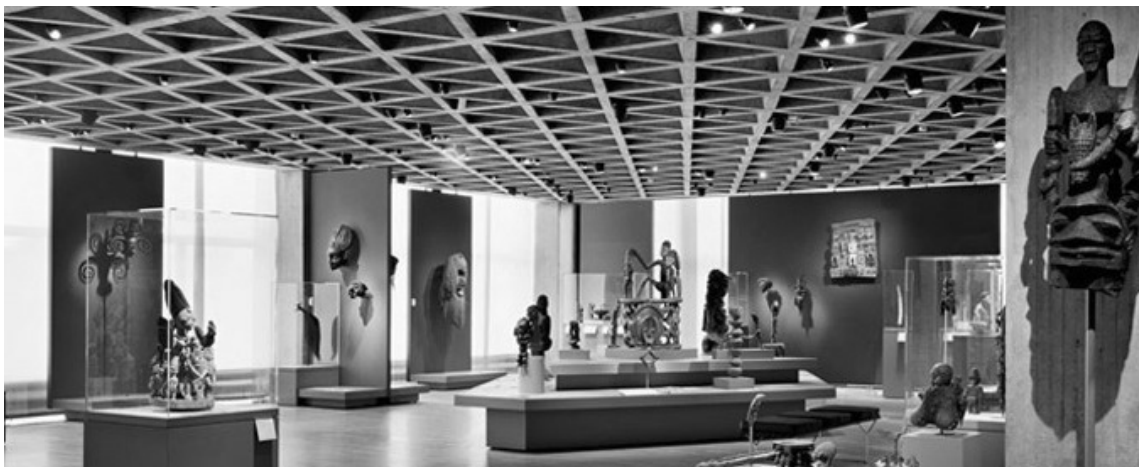
Imagen 75: Galería de Arte de la Universidad de Yale en New Haven, de Louis Kahn, 1951-1953. Vista de un forjado tetraédrico.
