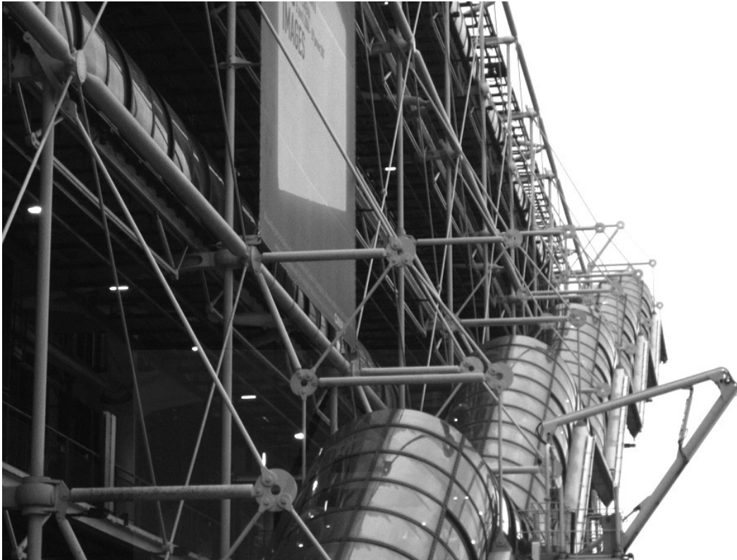
Imagen 82: Escalera mecánica suspendida de los extremos de las vigas Gerber, sobre la plaza. Fotografía del autor.
