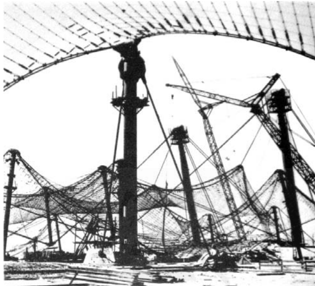
Imagen 142: Edificios para las Olimpiadas de Munich de 1972, vista de la malla de la cubierta del estadio inmediatamente luego de tendida. Ilustración extraída de " Frei Otto and the Munich Olympic Games (from the measuring experimental models to the computer determination of the pattern) " (Eeckhout, 1972, p.50).
