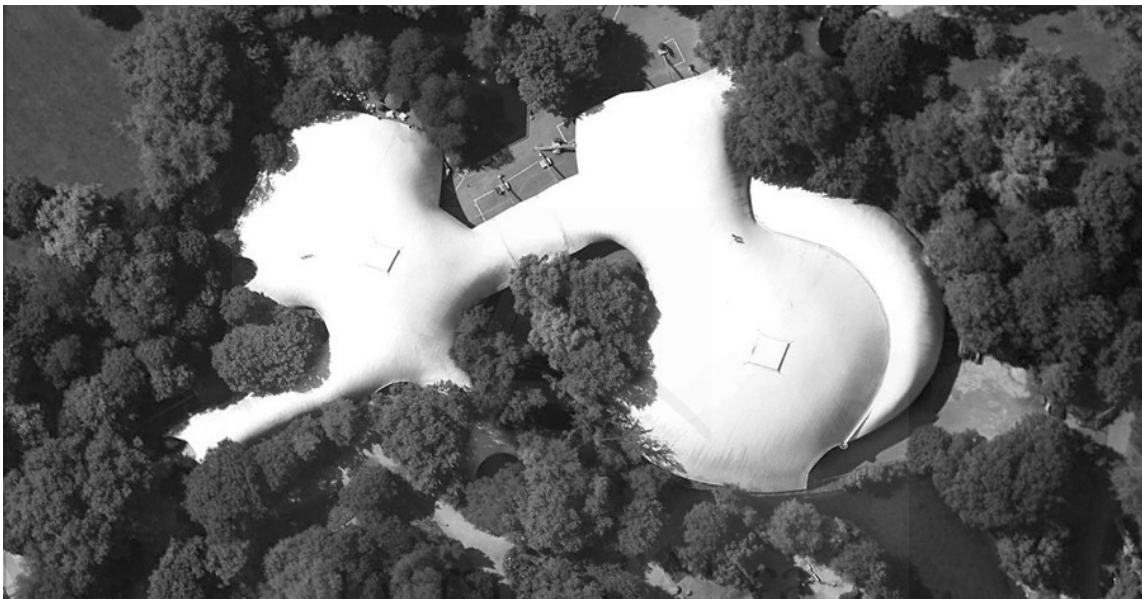
Imagen 148: Vista aérea de la cubierta del Multihalle de Mannheim desde 200 metros de altura. Imagen obtenida en enero de 2012 con el programa Google Earth.
