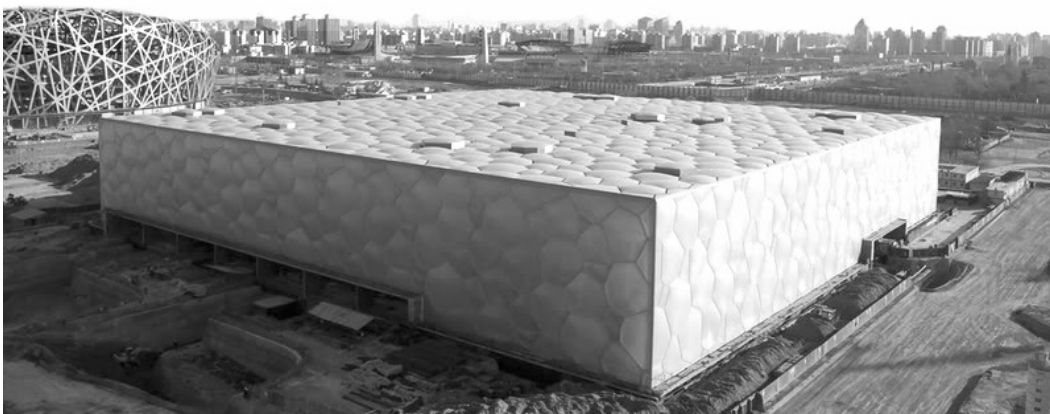
Imagen 95: El CNNP, antes y después de revestida la estructura. Ilustraciones extraídas de " Calado de espuma. Centro Nacional de Natación " (Arquitectura Viva, 2008, p.103) y de Internet < http://www.notinat.com.es/vernoticia.asp?id=1565 >.
