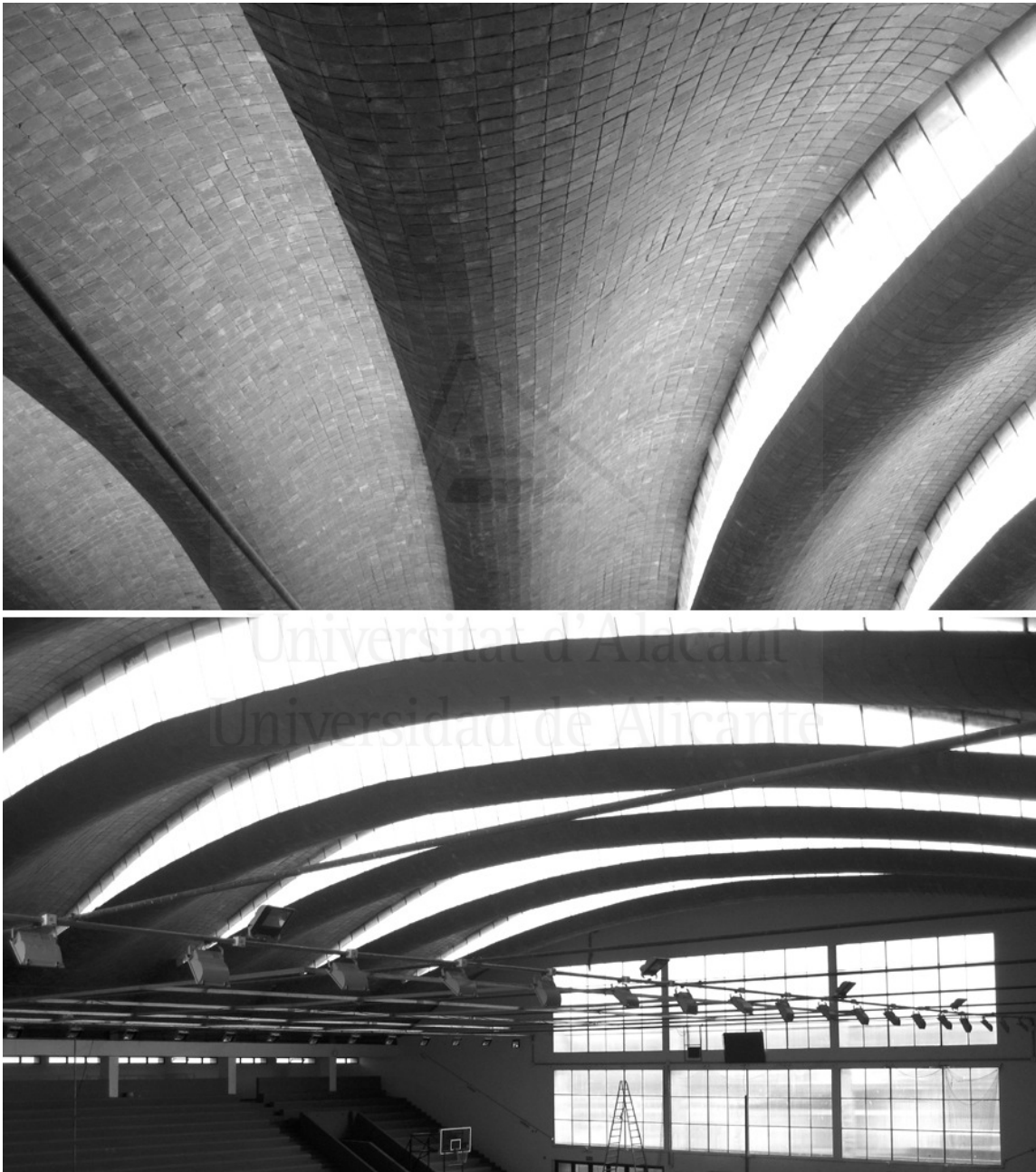
Imagen 121: Bóvedas gausas del gimnasio municipal de Durazno (1973-1975), Uruguay, de Eladio Dieste. Fotografías del autor.
