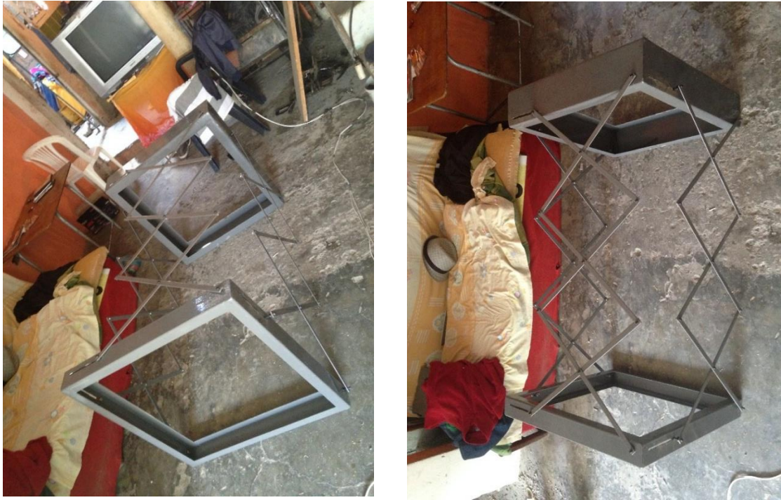
Fig. 60: Construcción de la Estructura para las pruebas
