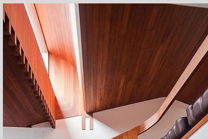
Figura 66: Detalle de linterna en Casa de Té Boa Nova (Leça da Palmeira, Portugal), Álvaro Siza 1958-1962.
