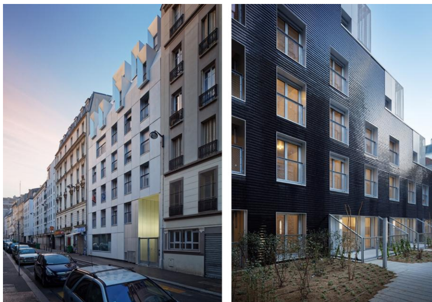
Figura 390: Vista de la fachada principal y la fachada interior hacia la medianera
