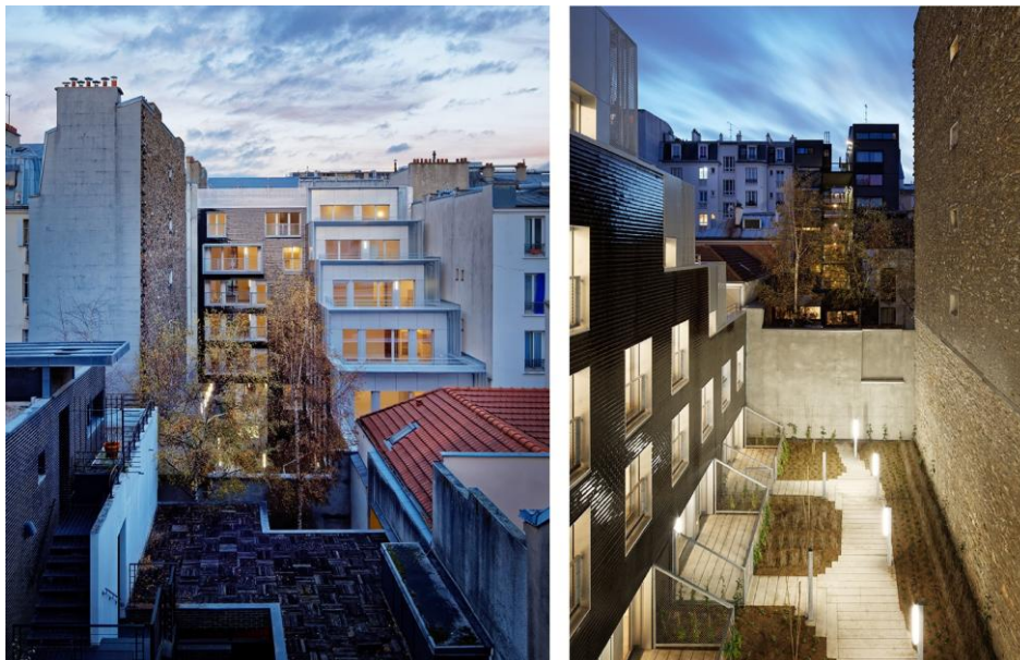
Figura 258: Vista interior del patio. Vista de las fachadas Suroeste del edificio y vista de las obstrucciones
