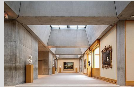
Figura 68: Estructura base de lucernario aplicada para iluminar y modular la galería de la 4ª planta. Centro Británico de Arte (New Haven, Connecticut, USA), Louis I. Kahn 1965-1974.
