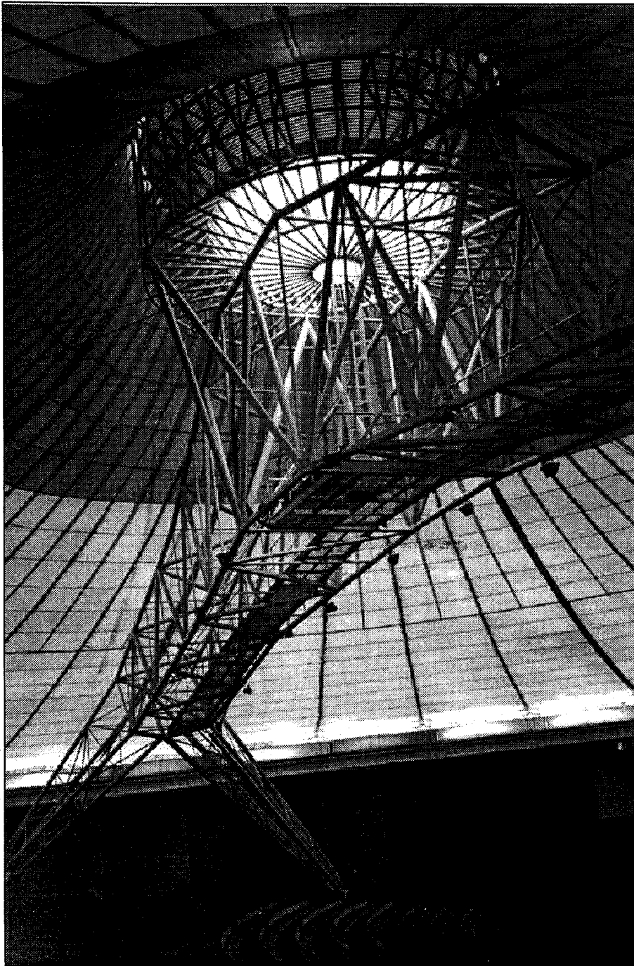
Figuras 148. Pórtico de sustentación de cubierta. Auditorio Araujo Vianna.
