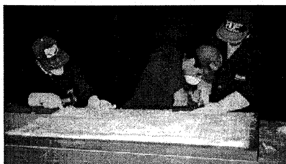
Figuras 187 y 188. Montaje de un panel absorbente. Auditorio Araujo Vianna.
