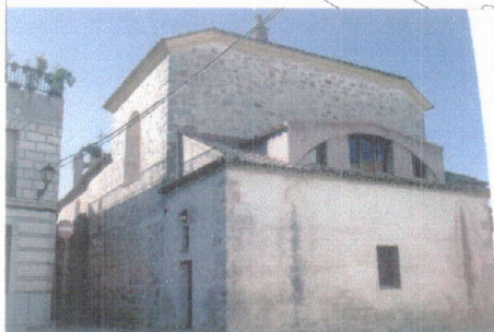
3. IGLESIA DE SANTIAGO. DOS TORRES.
