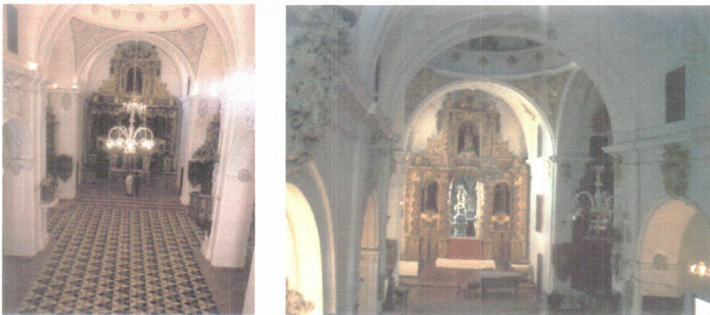
Fig. 8.2. Interior de la iglesia tras la restauración de 1992.
