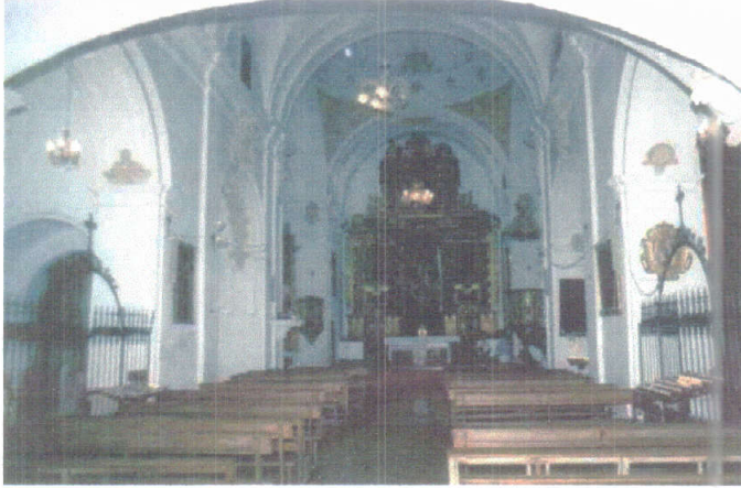
Fig. 8.1. Interior de la iglesia antes de la restauración.
