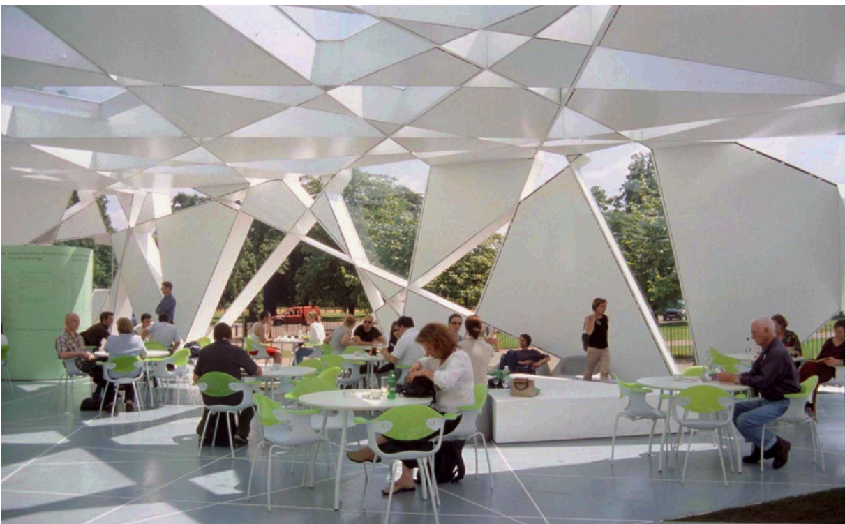
ABAJO: Serpentine Pavillion, Londres, 2002. Toyo Ito/Cecil Balmond © ARUP. Cortesía de Louisiana Museum, Denmark. Las constatables ramificaciones artísticas de estos patrones matemáticos muestran el verdadero genio de Balmond, como podemos observar en el diseño del Serpentine Pavillion de Londres, obra de Ito y Balmond. Aquí utiliza su conocimiento acerca de los algoritmos fractales, que actúan como el primer agente organizador, permitiendo que el pabellón exista como una entidad holística, donde la estructura y la forma son uno y lo mismo. Balmond destaca claramente de este modo, en la exploración de las ramificaciones artísticas de los patrones matemáticos, y se acerca más al antiguo principio filosófico de la téchne que ningún otro de sus contemporáneos. (Art.SignalBETA, Contemporary Art Magazine) http://magazine.art-signal.com
